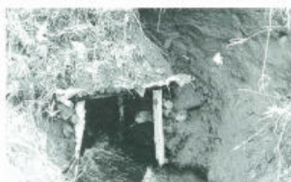
【昭和40年代前半の素掘隧道】
