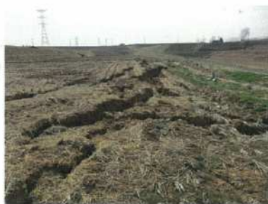
亀裂が入った農地〔一関市〕
