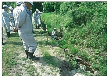
【花巻市の査定状況（水路）】
