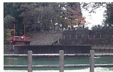
【特別に通水した円筒分水工】
