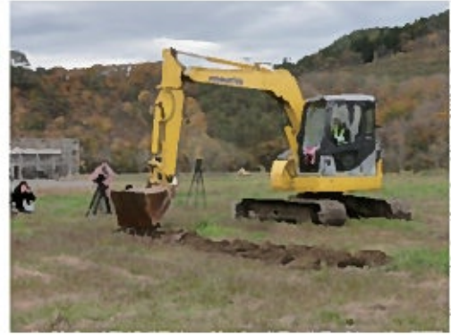
摂待地区工事の着工
