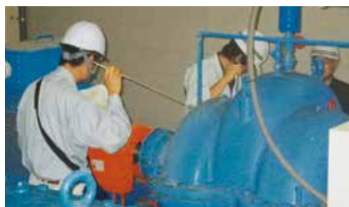
【聴診棒による異音の確認状況】
