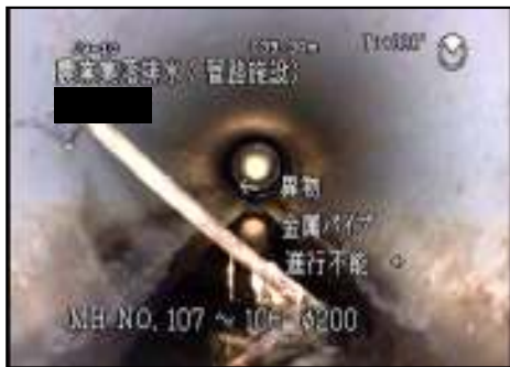
金属パイプ貫通状況
