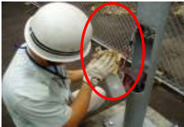
安定器交換状況（漏電回避）
