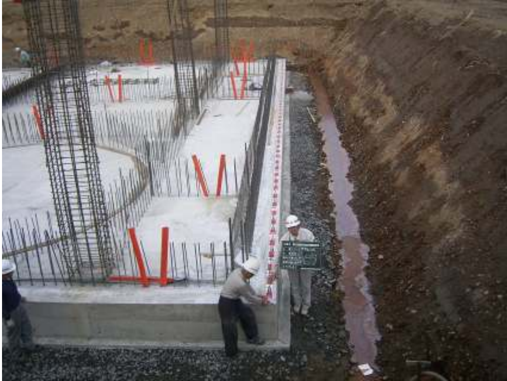
コンクリート出来形検測状況
