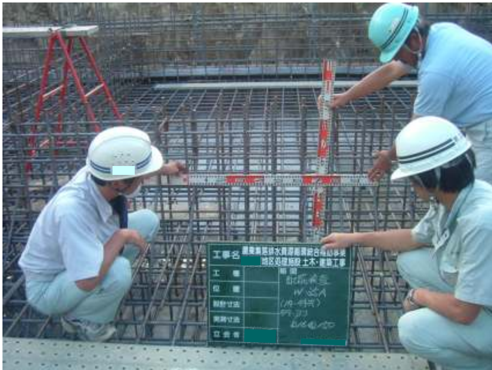
配筋検査状況
