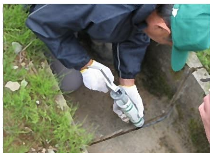
漏水箇所の目地補修等による水路の保全管理
