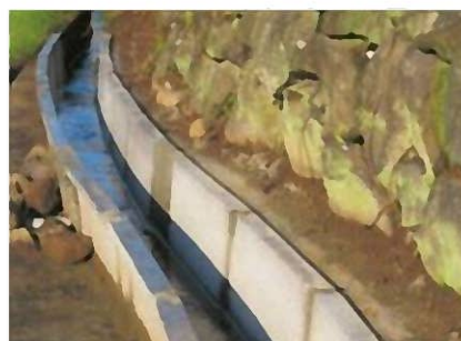
土水路をコンクリート水路へ
