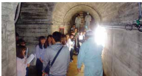
【豊沢ダム監査廊で説明を受ける学生】
