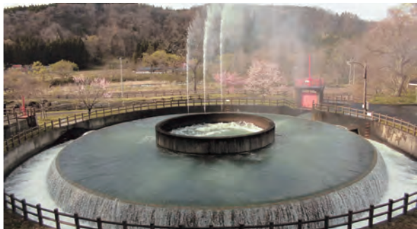
【放水された円筒分土工（胆沢平野土地改良区）】
