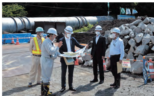
【導水路改修工事を視察する宮崎氏（写真中央）】
