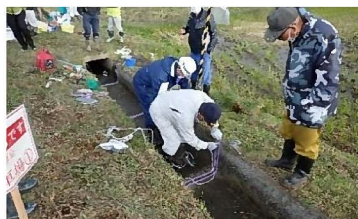
水路補修研修の様子
