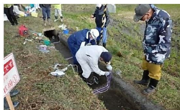
水路補修研修の様子
