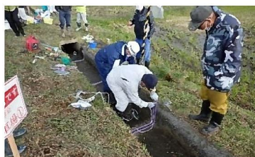
水路補修研修の様子
