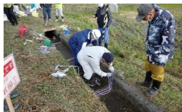
水路補修研修の様子
