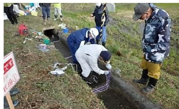
水路補修研修の様子
