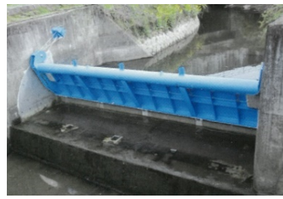
【ゲートの分解整備補修】
