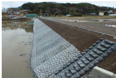
【ため池護岸の整備】
