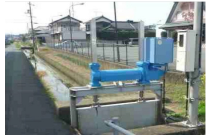
【樋門開閉機の電動化】
