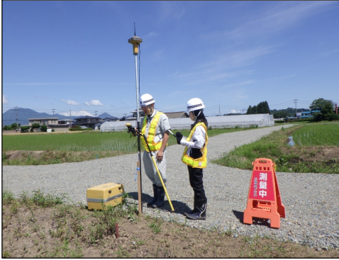
確定基準点への GNSS 測量機器の設置状況
