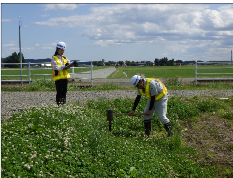
境界杭設置状況
