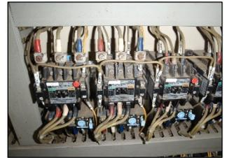
制御盤内の配線の劣化
