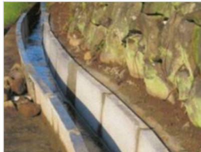
土水路をコンクリート水路へ
