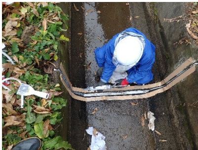
目地補修等による水路の保安全管理
