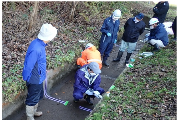
水路補修研修会の状況
