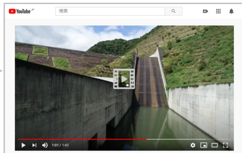
UAV 自動撮影動画（洪水吐の状況）
