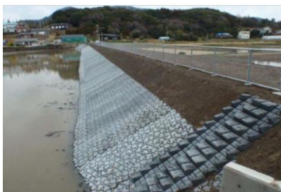
〔ため池護岸の整備〕
