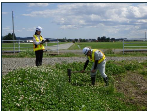
境界杭設置状況
