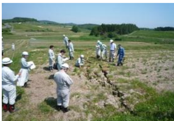
災害実地査定の説明・計測補助
