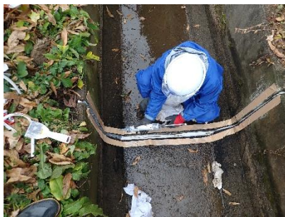
目地補修等による水路の保安全管理
