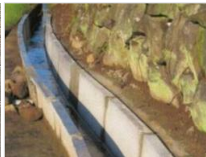
土水路をコンクリート水路へ
