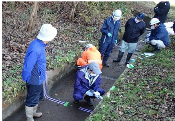
水路補修研修会の状況
