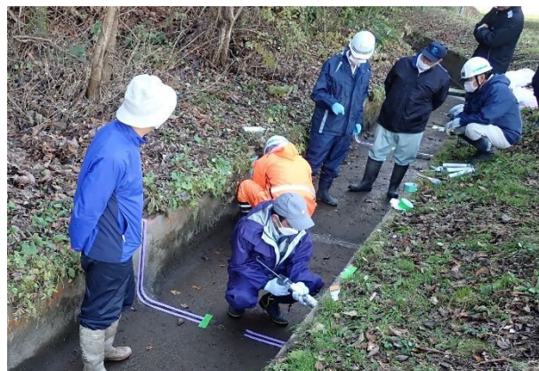
水路補修研修会の状況
