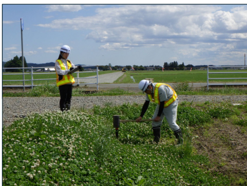
境界杭設置状況
