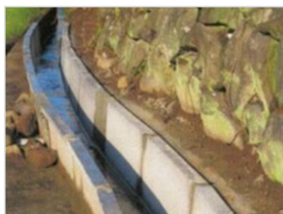
土水路をコンクリート水路へ
