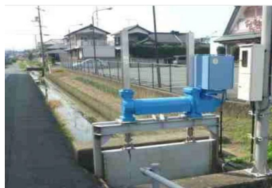
〔樋門開閉機の電動化〕
