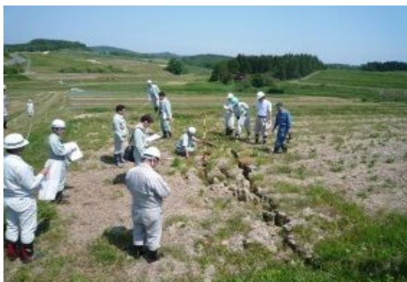
災害実地査定の説明・計測補助
