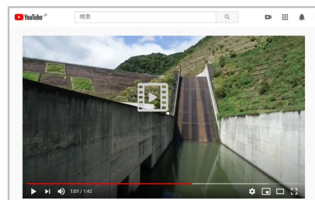
UAV 自動撮影動画（洪水吐の状況）
