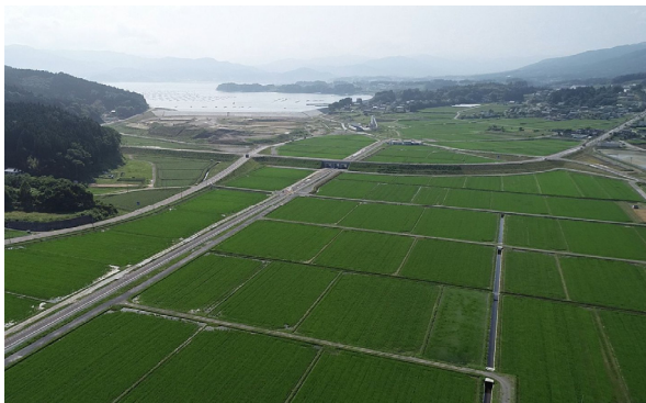
工事後のほ場整備地区を鳥瞰で撮影（陸前高田市 小友地区）
