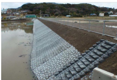
〔ため池護岸の整備〕
