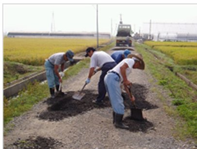
砂利の補充等による農道の保安全管理
