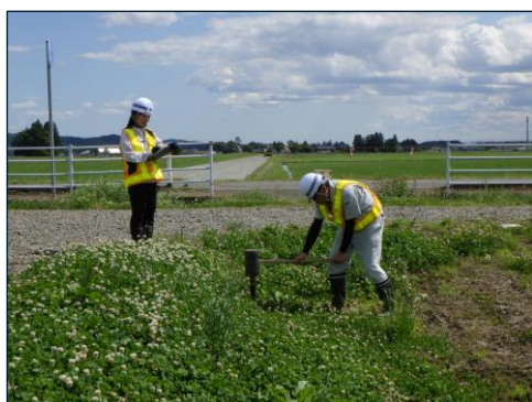
境界杭設置状況
