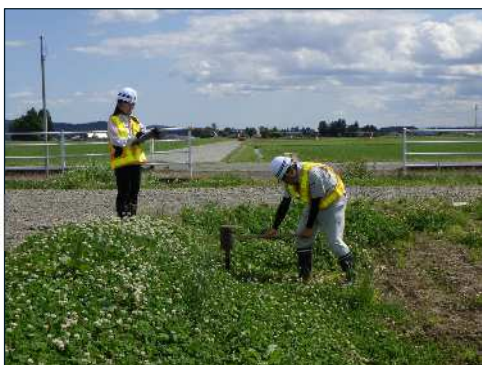
境界杭設置状況
