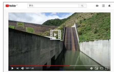
UAV 自動撮影動画（洪水吐の状況）
