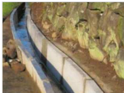
土水路をコンクリート水路へ
