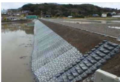
〔ため池護岸の整備〕
