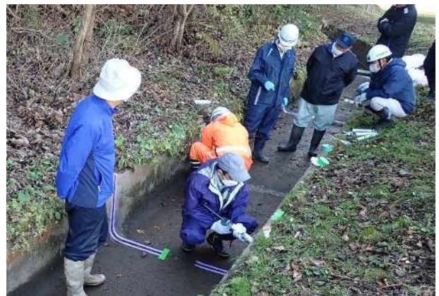
水路補修研修会の状況
