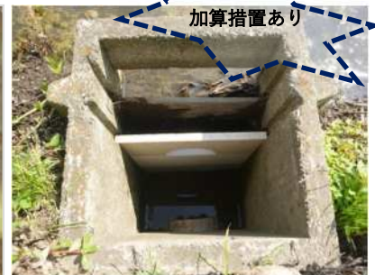
排水の流量調整による水田の雨水貯留機能の強化（田んぼダム）
