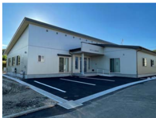
【土地改良区新事務所】
