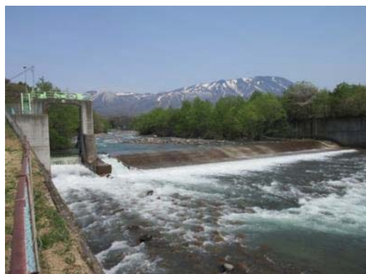
【駒木野頭首工】
