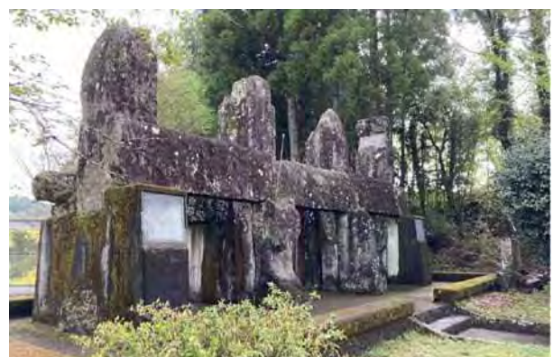
【百太郎溝取水口旧樋門】
