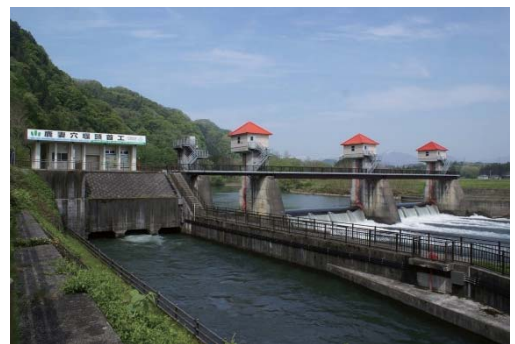
【鹿妻穴堰頭首工】
