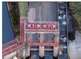
(農業水利施設)
