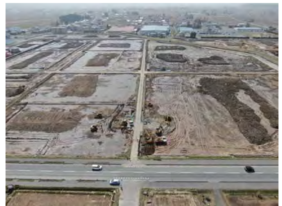
【ほ場整備現場写真】
