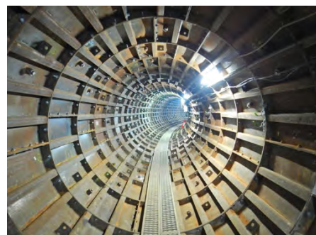
【国営かんがい排水事業のトンネル工事で使用したシールドマシンと掘削後一次覆工した導水トンネル】
