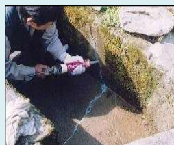
ひび割れの補修
