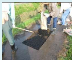
農道の部分補修
