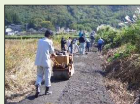
未舗装農道の舗装
