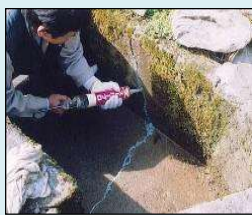
ひび割れの補修
