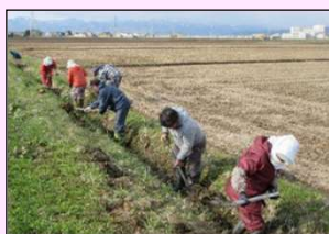
水路の泥上げ
