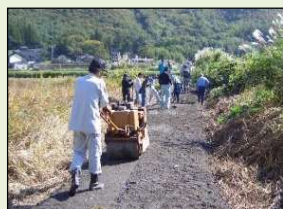
未舗装農道の舗装
