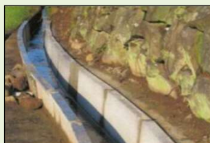
素堀り水路からの更新
