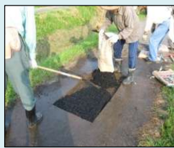
農道の部分補修
