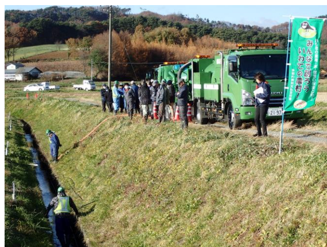
▲ 暗渠排水の洗浄を見学する参加者
