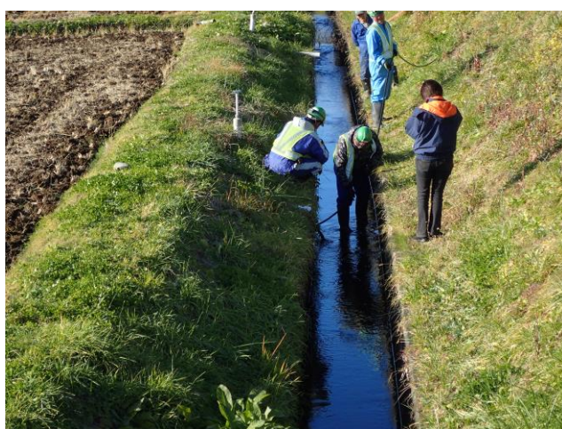
▲ 暗渠排水孔から洗浄ホースを挿入
