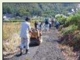
未舗装農道の舗装
