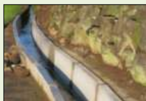
素堀り水路からの更新
