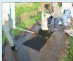
農道の部分補修
