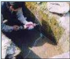
ひび割れの補修
