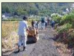
未舗装農道の舗装
