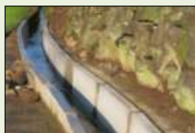
素堀り水路からの更新
