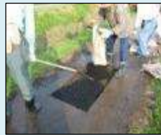
農道の部分補修
