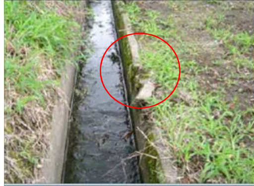
部分的な破損・漏水等はないか
