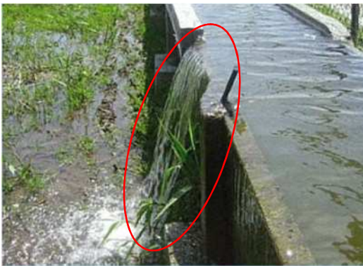
側壁からの溢水等はないか
