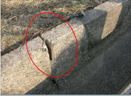
目地の損傷・ひび割れ等はないか
