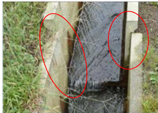
水路のズレ、泥や土砂の堆積等はないか
