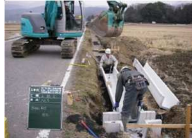
コンクリート水路へ
