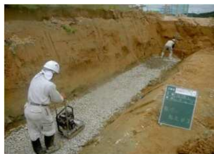
フリウム等設置に必要となる基礎砕石の施工。
