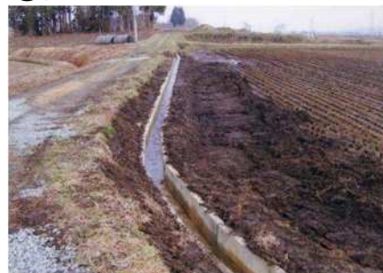
法面を整形して完成。
