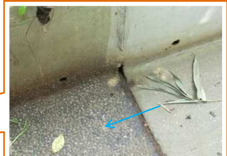
ドリルであけた排水孔
