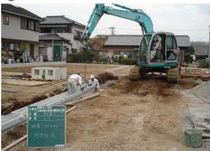
基礎砕石の上にフリウムを設置。
