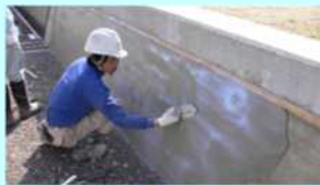
老朽化した水路壁のコーティング
