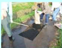
農道の部分補修
