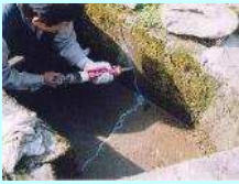
水路のひび割れ補修
