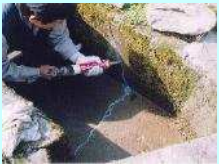
水路のひび割れ補修
