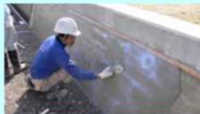
老朽化した水路壁のコーティング
