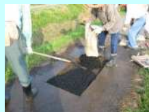
農道の部分補修
