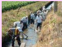
水路の泥上げ
