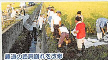
農道の路肩崩れを改修
