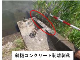
斜樋コンクリート剥離剥落
