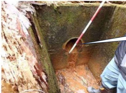
底樋が破損し、堤体土が流出している可能性あり
