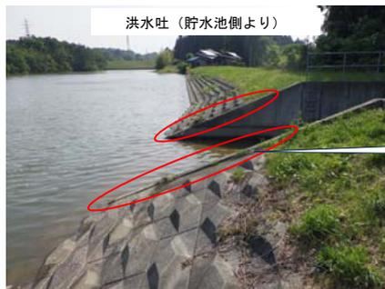
護岸ブロック等で覆われている場合でも、ブロックの隙間からブロック裏側の土が流亡していないか確認することが重要
