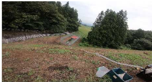
吐出し管設置状況
