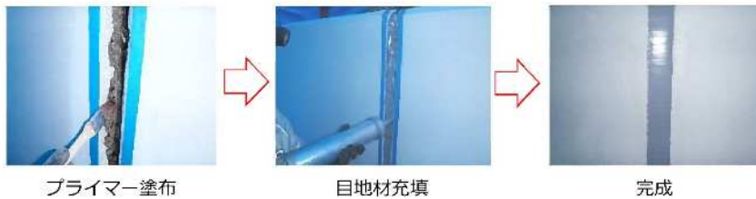
目地補修工法（目地充填工法）例
