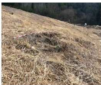
堤体の陥没
