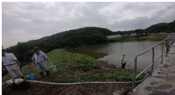
吸込み管設置状況
