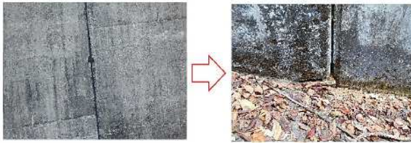
目地補修工法（目地充填工法）例
