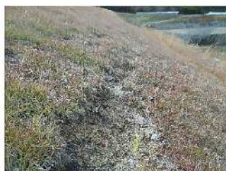
滲み出しによる土砂流出
