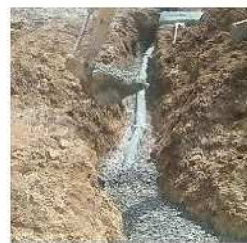
漏水処理施工例
