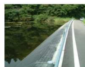
安全ネットの設置
