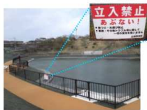
転落防護柵と警告看板の設置
