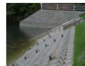
法面を這い上がりやすい張ブロック(防災型)の設置
