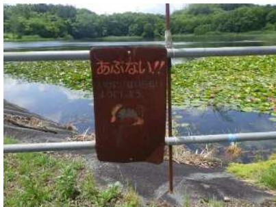
写真43：看板の劣化、破損
